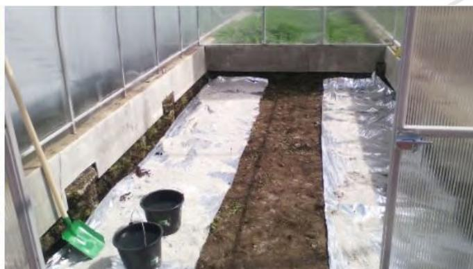
Снимается плодородный слой грунта (30-40 см). Раскладывается теплоизоляционное покрытие с низким коэффициентом влагопоглощения (например, вспененный полистирол), чтобы минимизировать теплопотери вниз.
