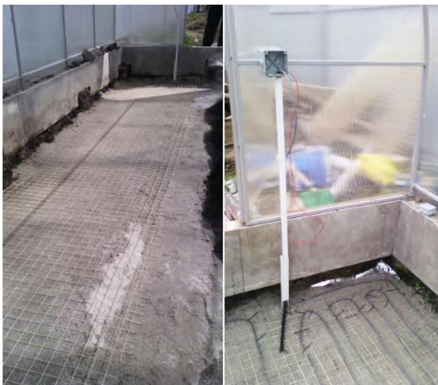
Наносится слой песка (5см), поливается водой и утрамбовывается, чтобы не было воздушных пузырьков. На слой песка, насыпанный над кабелем, укладывают мелкоячеистую металлическую сетку или перфорированный асбо-цементный лист для защиты кабеля от повреждений лопатами или другими строительными инструментами. Устанавливается терморегулятор. Плодородный грунт (30-40 см) насыпают поверх песка.
