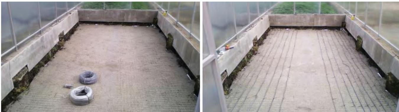
Укладывают нагревательный кабель методом змейки – с помощью монтажной ленты. Расстояние между витками греющего кабеля должно быть около 15 см.
