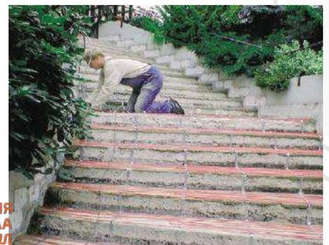
Для эффективного стаивания льда нагревательный кабель нужно расположить как можно ближе к краям каждой ступени. Кабель укладывается непосредственно на бетон и должен быть покрыт им на 3 см.
